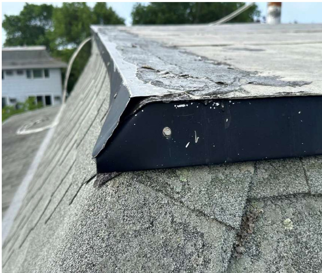
P-13 Exhaust Fan
