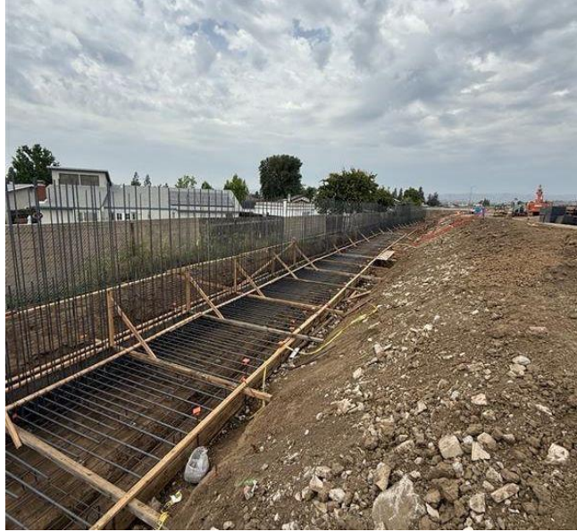
Reconstrucción del nuevo muro de sonido a lo largo de la rampa de entrada SR-91 en dirección oeste cerca de Lakeview Avenue.
