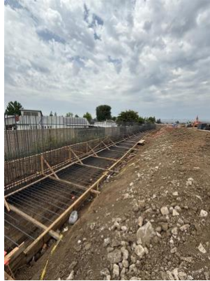
Cuadrillas reconstruyendo el nuevo muro de sonido a lo largo de la rampa de entrada SR-91 en dirección oeste cerca de Lakeview Avenue.
