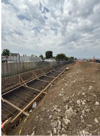
Equipos reconstruyen el nuevo muro acústico a lo largo de la rampa de entrada WB SR-91 cerca de Lakeview Avenue.
