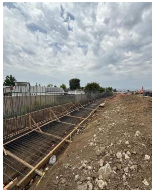
Equipos reconstruyen el nuevo muro acústico a lo largo de la rampa de entrada WB SR-91 cerca de Lakeview Avenue.
