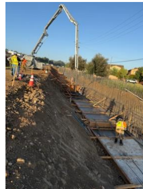
Cuadrillas vertiendo concreto para construir la base del nuevo muro de sonido.
