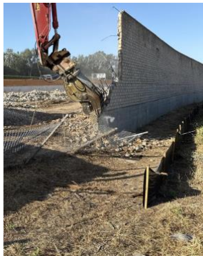
Los equipos están demoliendo el antiguo muro de sonido para dar lugar a la nueva rampa de acceso SB SR-55 que se construirá.
