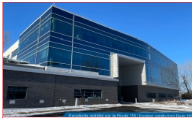
Espace bureau de 8 745 pi 2
