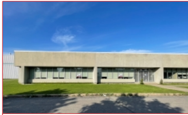
Espace bureau de 3 201 pi 2
