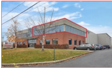
Espace bureau de 2 500 pi 2
