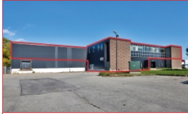
Espace bureau et entrepot
