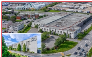
Centre de distribution
