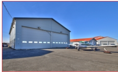
Bâtiment de 4 200 pi²
