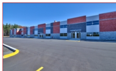
Espace industriel de 1 860 pi²
