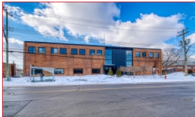
Espace industriel de 61 900 pi²
