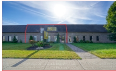
Situé dans le parc industriel de
