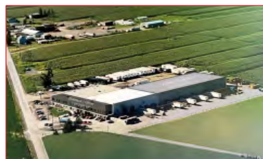
Entrepôt avec bureaux
