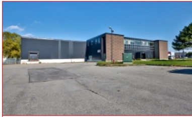
Bâtiment industriel de 78 182 pi²
