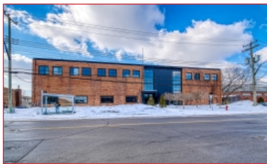
Espace industriel de 61 900 pi²
