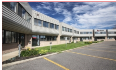
Bureaux et entreposage
