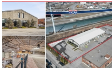
Espace industriel de 14 135 pi²
