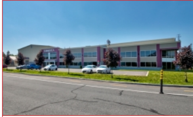
Espace industriel de 32 080 pi²
