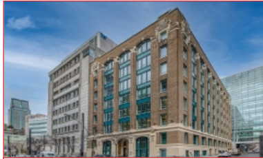
Espace bureau aménagé
