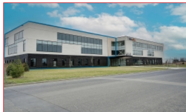
Espace bureau divisible de 22 134 pi²
