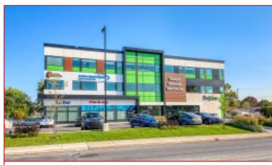
Deux espaces de bureaux
