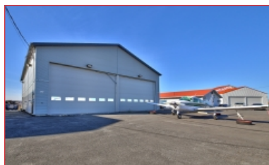
Bâtiment de 4 200 pi²
