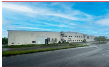
Bâtiment de 91 459 pi²
