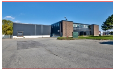
Bâtiment industriel de 78 182 pi²
