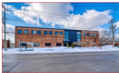
Espace industriel de 61 900 pi²
