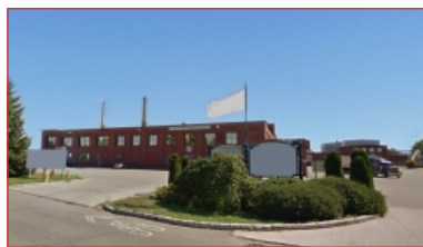
Site industriel à redévelopper
