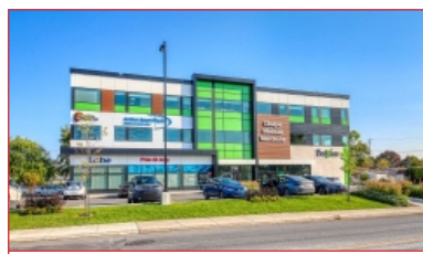
Deux espaces de bureaux
