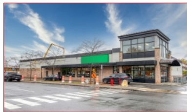
Bâtiment commercial de 17 435 pi²
