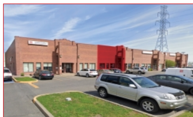
Entrepôt industriel de 7 500 pi²
