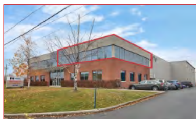
Espace bureau de 2 500 pi 2
