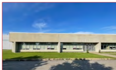
Espace bureau de 3 201 pi 2
