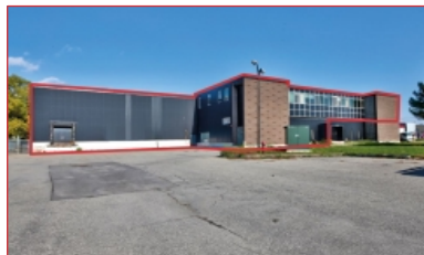
Espace bureau et entrepot
