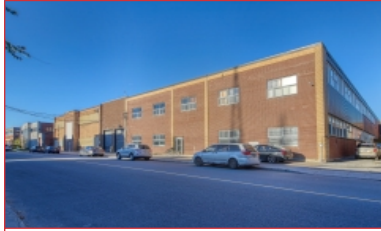
Bâtiment de 92 132 pi²
