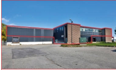
Espace bureau et entrepot
