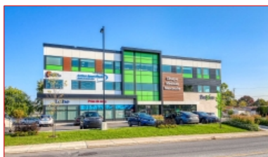
Deux espaces de bureaux
