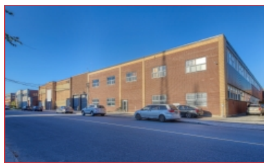
Bâtiment de 92 132 pi²
