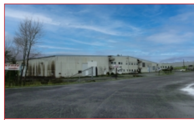
Bâtiment de 91 459 pi²
