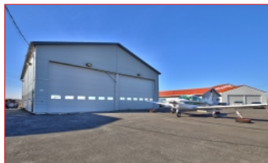
Bâtiment de 4 200 pi²
