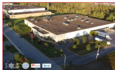
Entrepôt de 85 707 pi² réfrigéré
