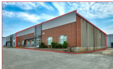
Espace industriel de 9 000 pi²
