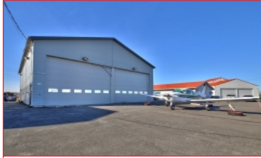
Bâtiment de 4 200 pi²
