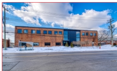
Espace industriel de 61 900 pi²
