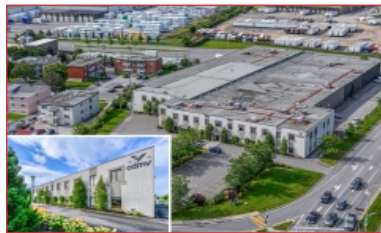
Centre de distribution
