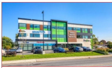
Deux espaces de bureaux
