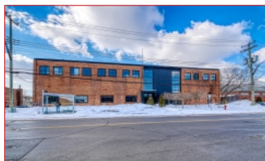
Espace industriel de 61 900 pi²
