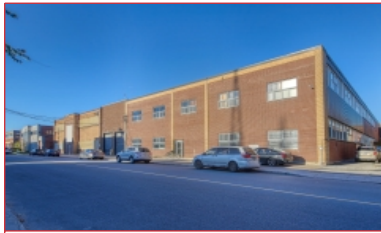
Bâtiment de 92 132 pi²
