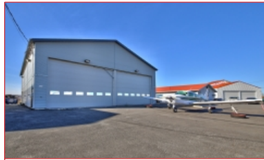
Bâtiment de 4 200 pi²
