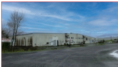
Bâtiment de 91 459 pi²
