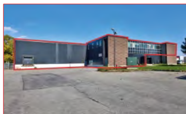
Espace bureau et entrepot
