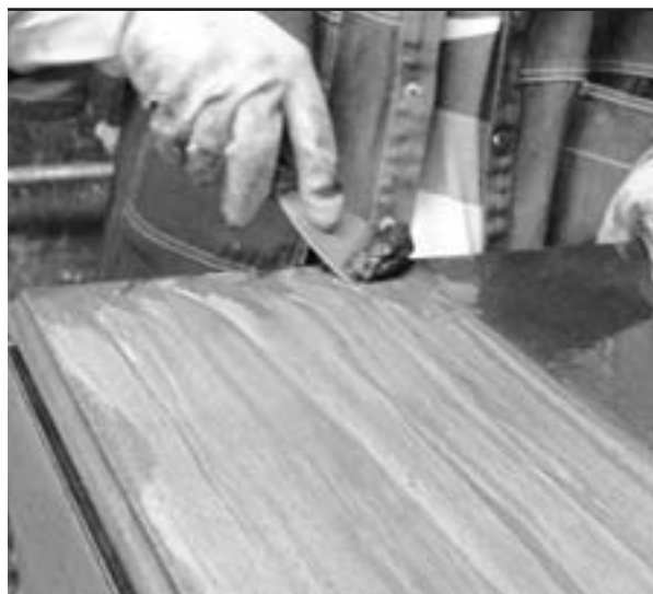
Appliquez le décapant sur une petite surface limitée.
