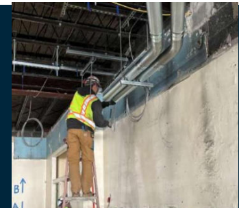
Electrical Conduit Installation
