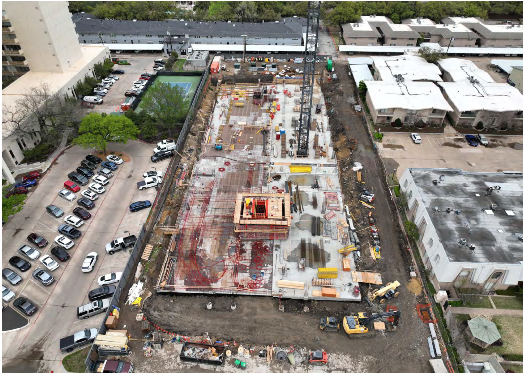
Site overview, level 1 pour 3 poured 3/21.
