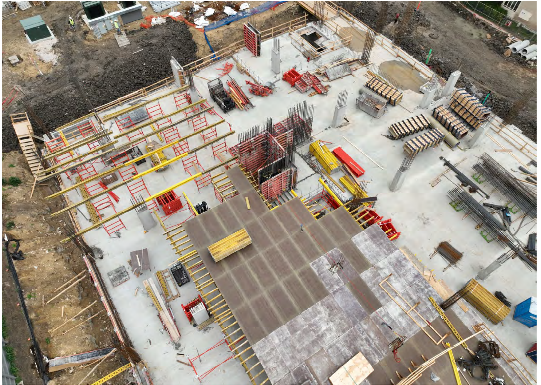
Level 2 decking ongoing for level 2 pour 1.
