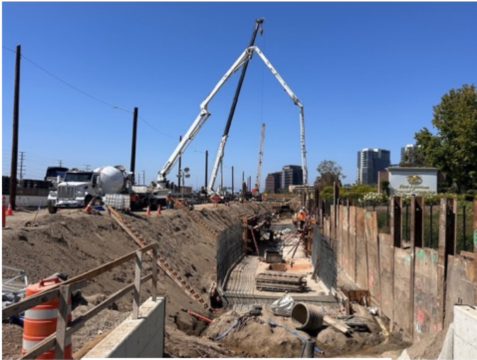
Vertido de concreto en el canal de carril.
