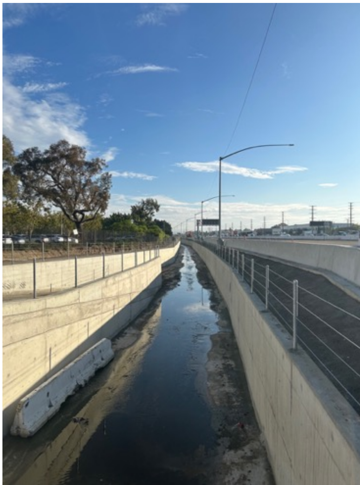
Canal del Carril reconstruido a partir de septiembre de 2025.
