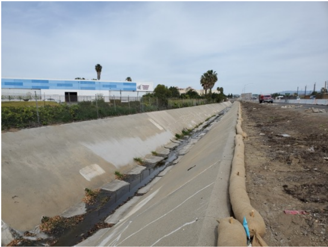
Canal del Carril antes de la demolición y reconstrucción.
