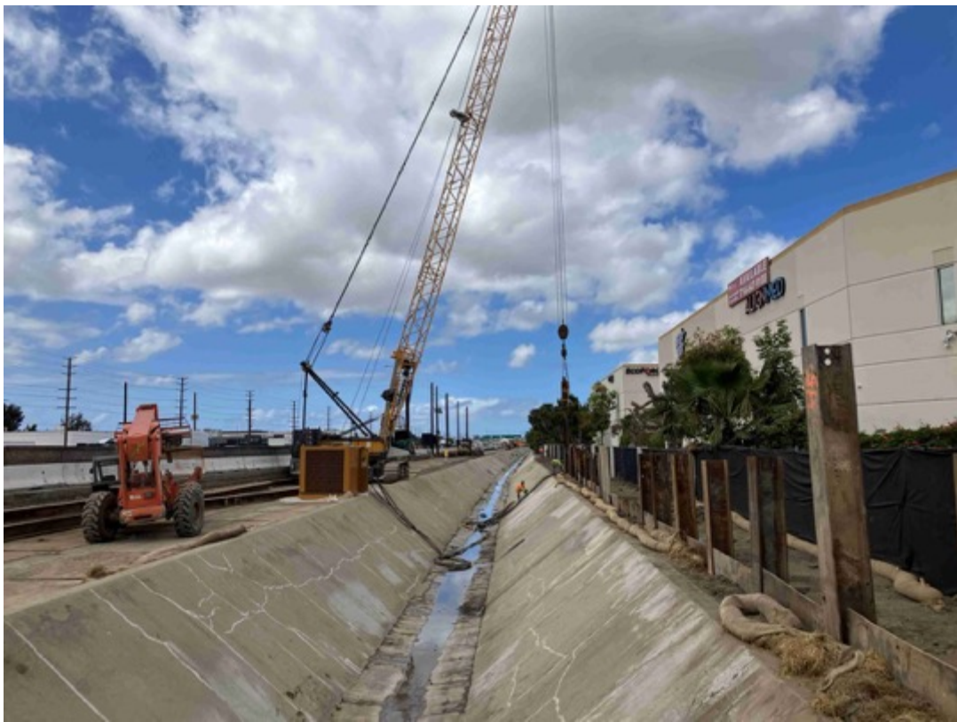
Instalación de apuntalamiento.
