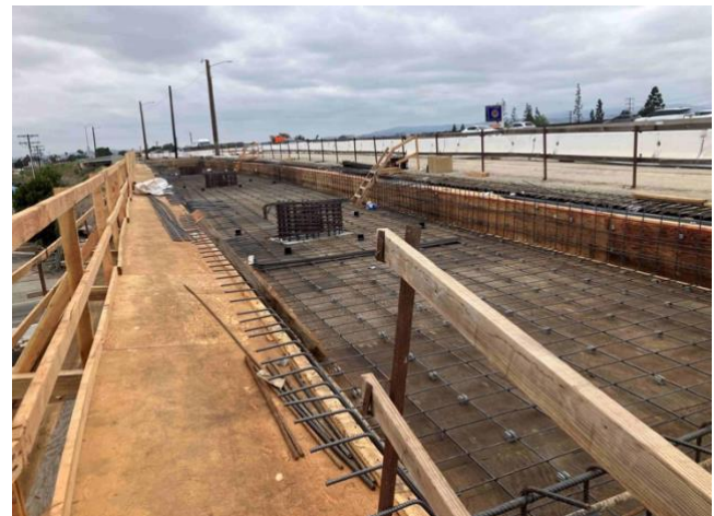
Instalación de barras de refuerzo en el puente de Edinger Avenue.
