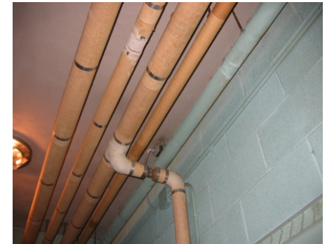
Asbestos Pipe Wrap
